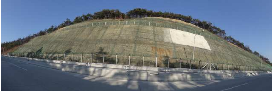
영천절토 34 (관리이정 1.890~2.150km / 5공구 군위R-A(중양)STA.1+890~2+150)
