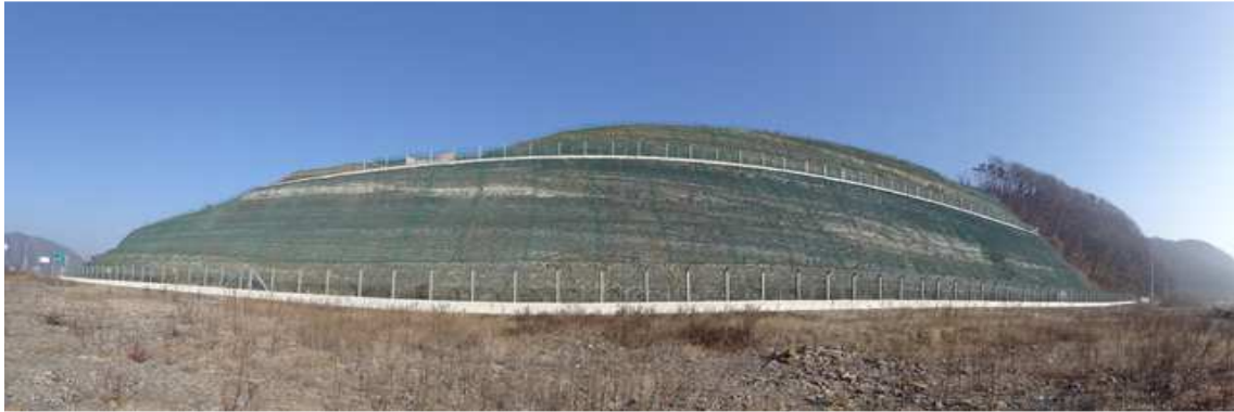
상주절토 35 (관리이정 0.160~0.42km / 6공구 STA.0+160~0+420(이설도로#2))
