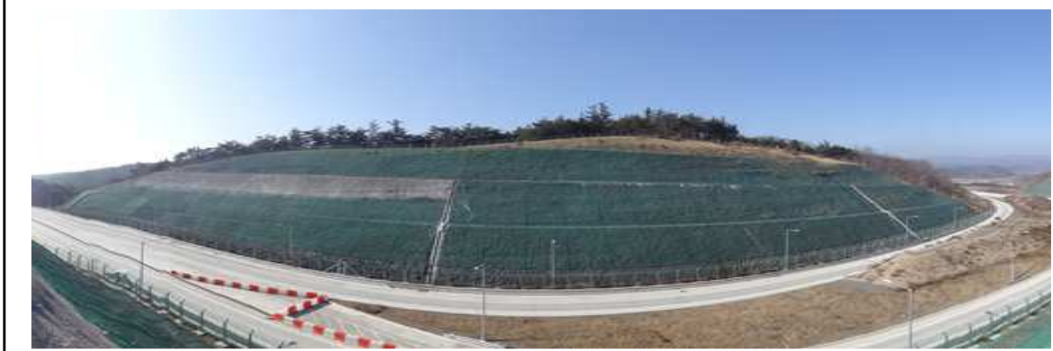
영천절토 61 (관리이정 0.320~0.537km / 8공구 화산JCT RD우측 STA.0+320~0+537)
