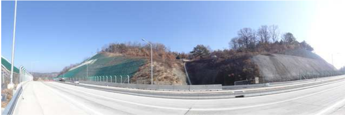
영천절토 58 (관리이정 0.920~1.340km / 8공구 화산JCT RA우측 STA.0+920~1+340)
