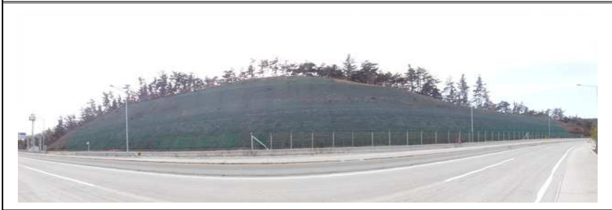
영천절토 59 (관리이정 1.600~1.723km / 8공구 화산JCT RA좌측 STA.1+600~1+723)
