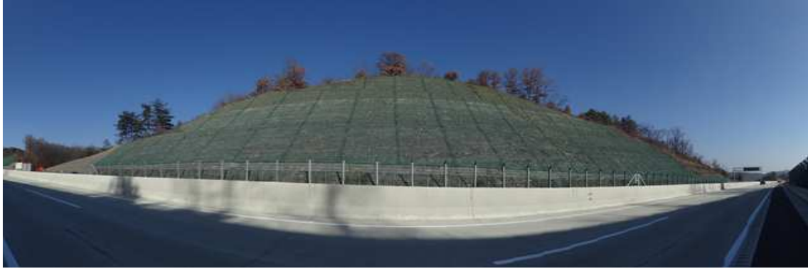
상주절토 50 (관리이정 71.71.478~71.718km / 8공구 STA.6+120~6+360)
